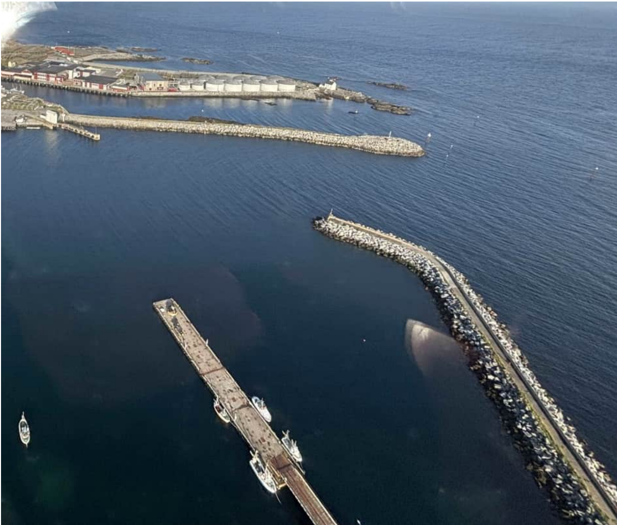
Figur 15: Dagens moloer på Værøy. Det er viktig at nye moloer etableres med materialer som harmonerer med moloer i området og får gode tilslutninger til stedet og ivaretar karakteren.
