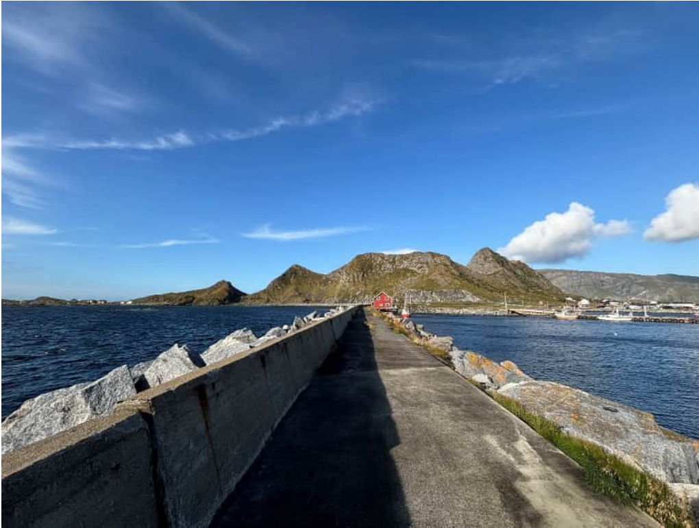
Figur 5-4: Tyvnesmoloen, sett fra ytterkant av molo mot land.
