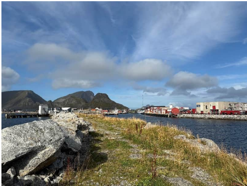
Figur 5-3: Røstnesvågmoloen, sett fra ytterst på moloen, mot østre del av havnen [5].
