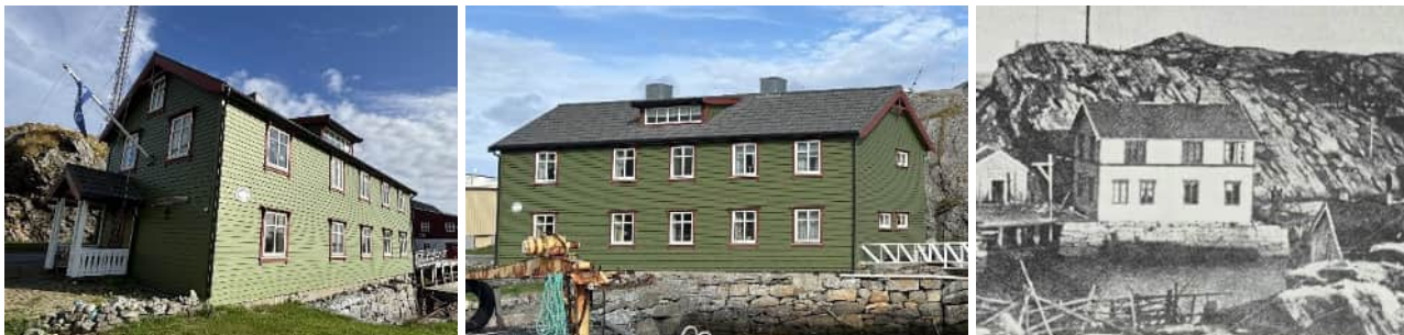
Figur 5-7 Telegrafstasjonen, lengst til høyre fra om lag 1920 [16]. Det eldre bildet viser at bygningen er utvidet i lengden, har fått et takopplett og endret inngangsparti. Vinduer og tak er skifta i nyere tid.
