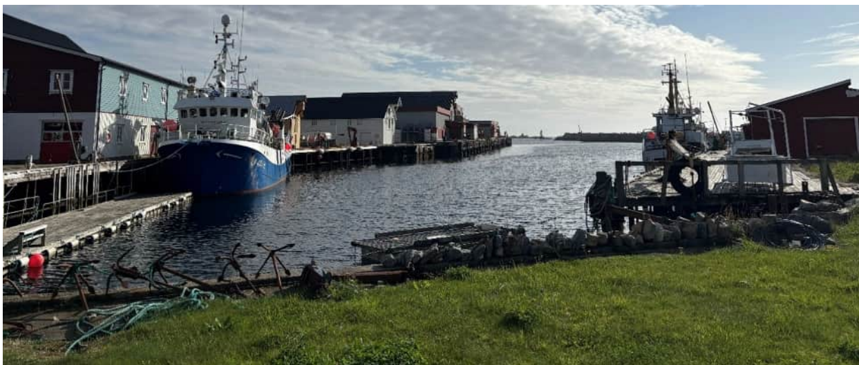
Figur 6-2 Dagens utsikt mot sør fra innerst i Røstnesvågen (september 2025). Utfylling av kaier og Lofoten Vikings anlegg til høyre i bildet har til en viss grad allerede redusert tilknytningen til fjorden.
