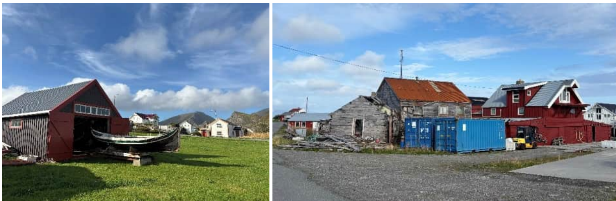
Figur 5-13 Fra vestsida av Røstnesvågen. Til høyre: naust flytta fra fyrstasjonen. Til venstre: eldre, forfalne bygninger og bua Synsvollteigen .
