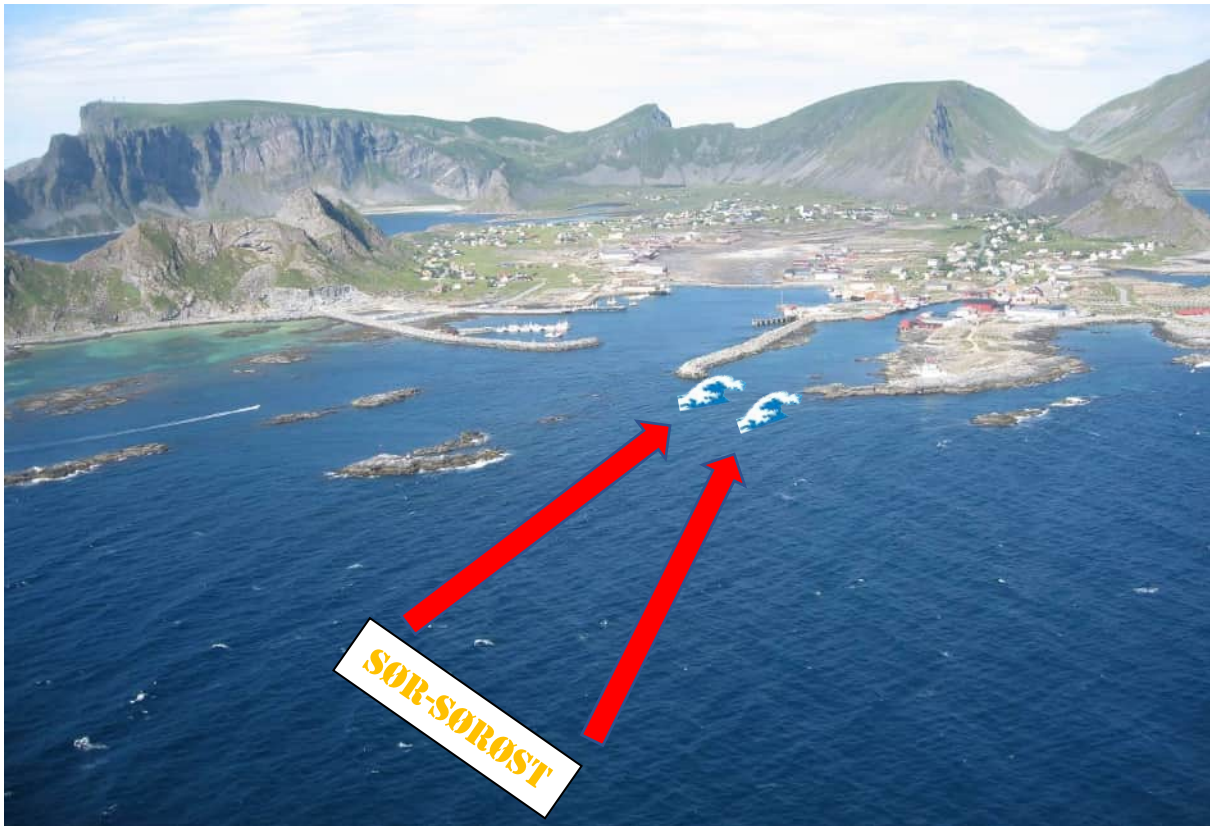
Illustrasjon 13: Dagens løsning gir ikke god nok dekning mot drag og bølger ved uvær fra sør-sørøst.
