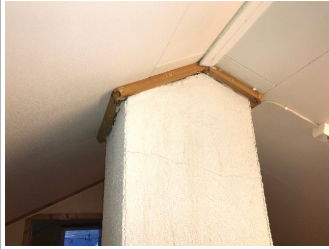
Pipe loft, betydelig oppsprekking i puss.
