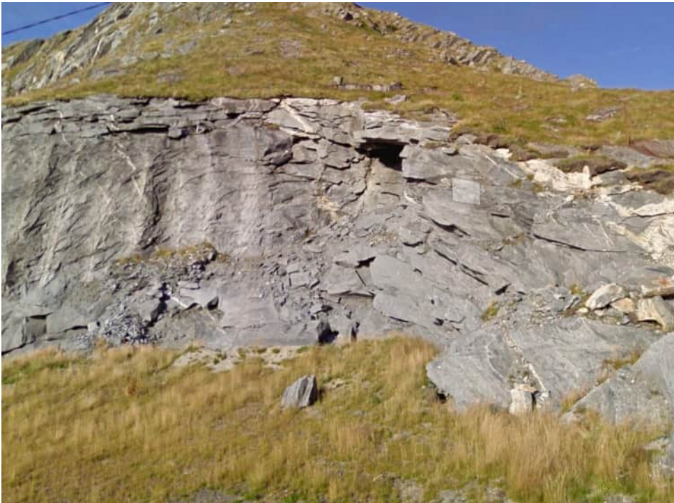
Figur 6. Gammelt steinbrudd, hvor det tidvis vil falle ut stein fra selve skjæringen. Terrenget under steinbruddet er flatt, med god dempning, hentet fra google street-view.
