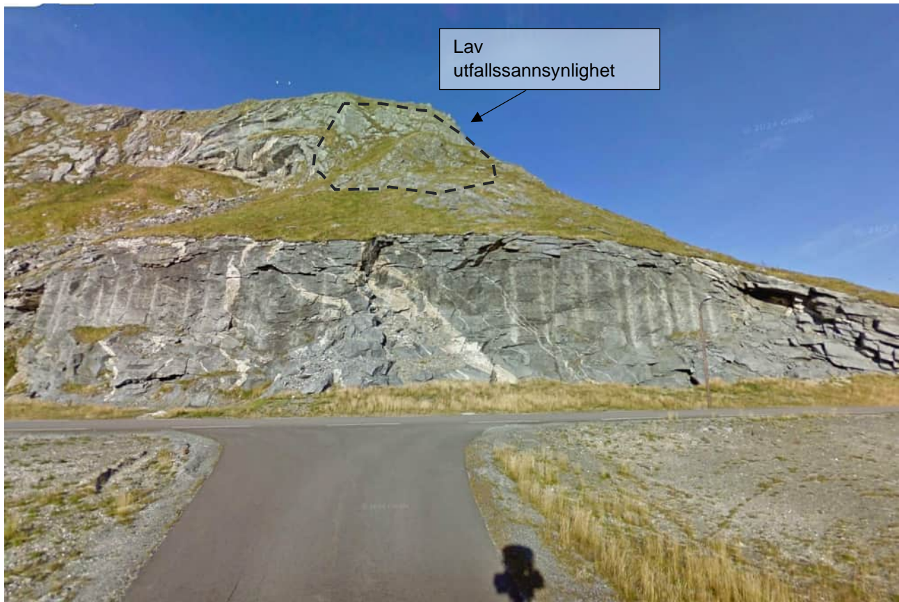
Figur 13. Løsnemråde steinsprang er i øvre del av fjellsiden opp mot ryggen, hentet fra google street-view.
