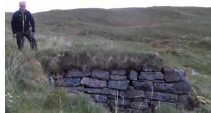
Nordlandsmarka: Grava for 300 m-hold. Stativet for skivene er for langt råtnet bort
