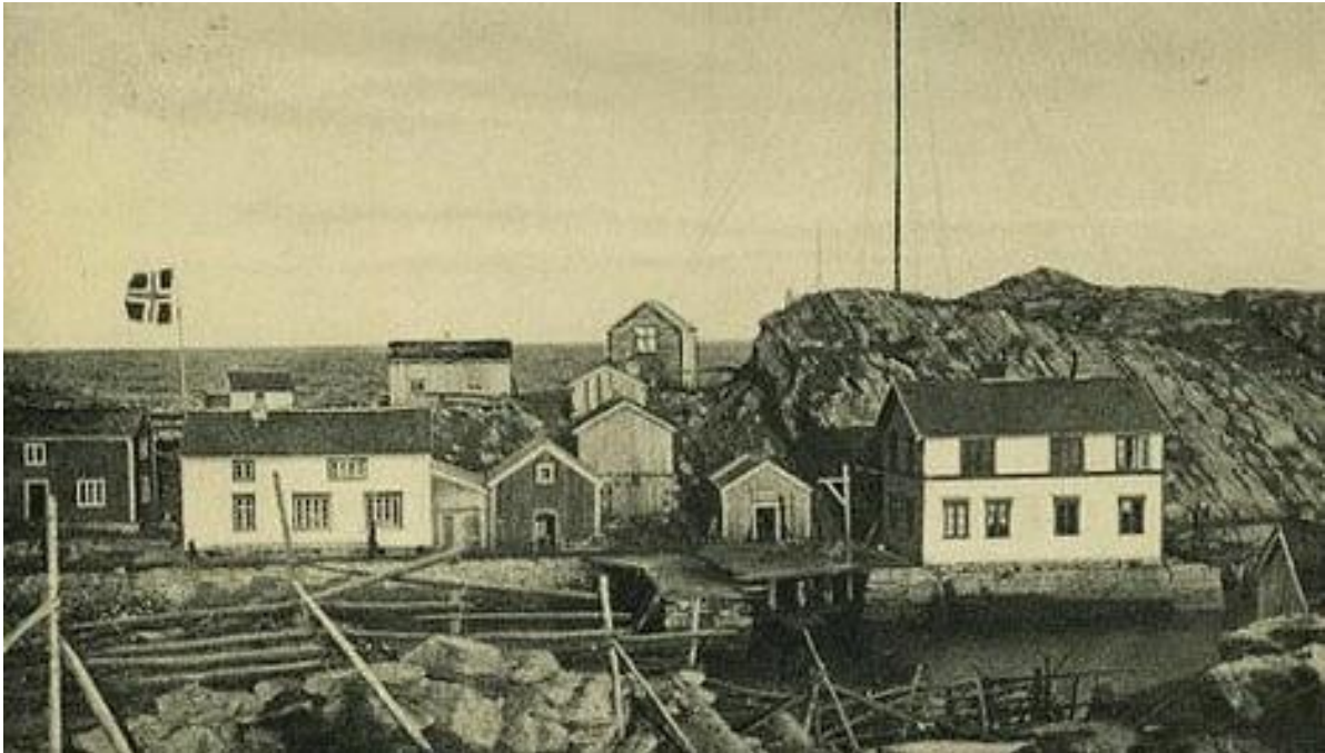
Telegrafene i Røstnesvågen ble åpnet i 1910.
