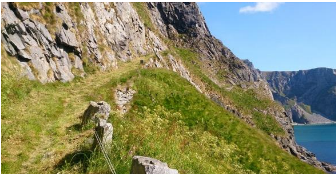
Mye av arbeidet med veien fra Måstad til Eidet ble utført som «nødsarbeid» på 1920- og 1930-tallet.
